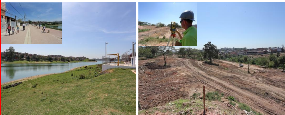
Vistoria do terreno do futuro Conjunto Habitacional América do Sul Urbanização da Comunidade Pabreu/Prainha - Grajaú
