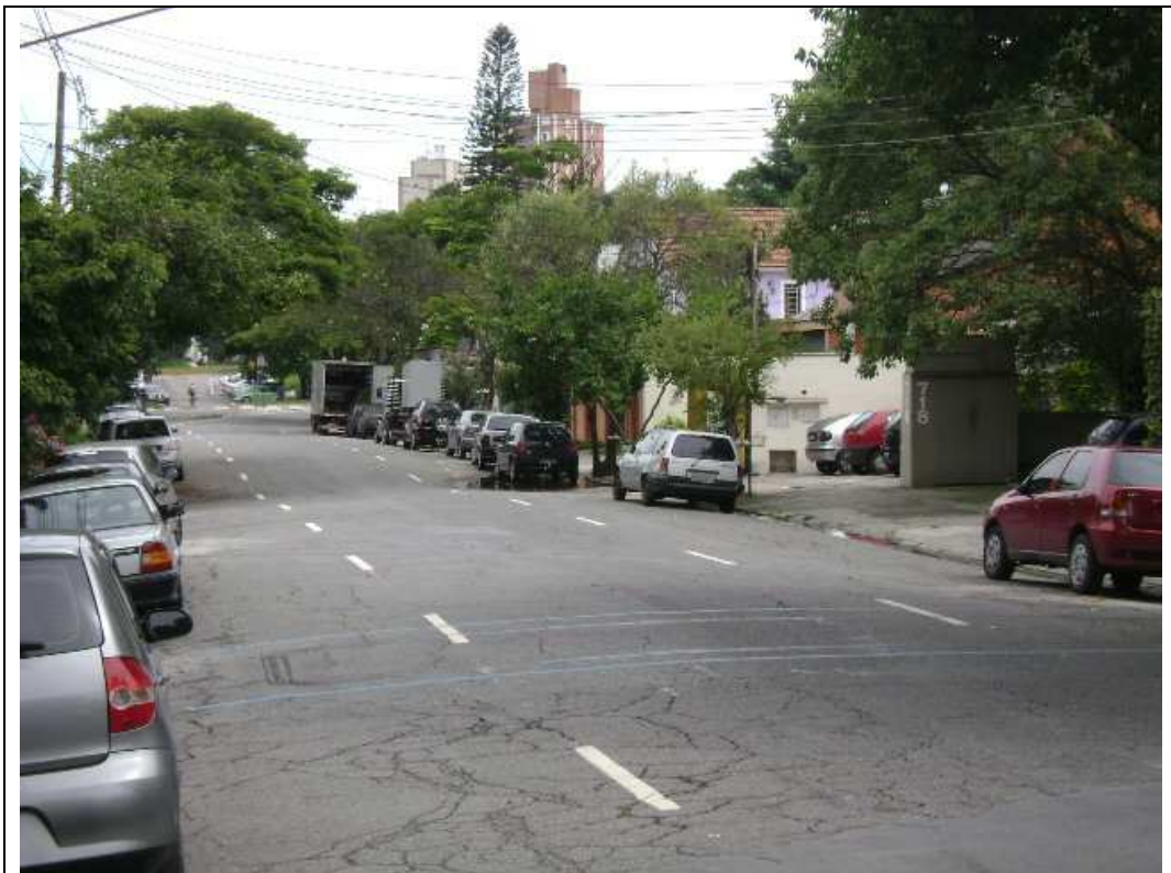
Vista do recalque Rua Alvarenga com a Rua Camargo - fev/09
