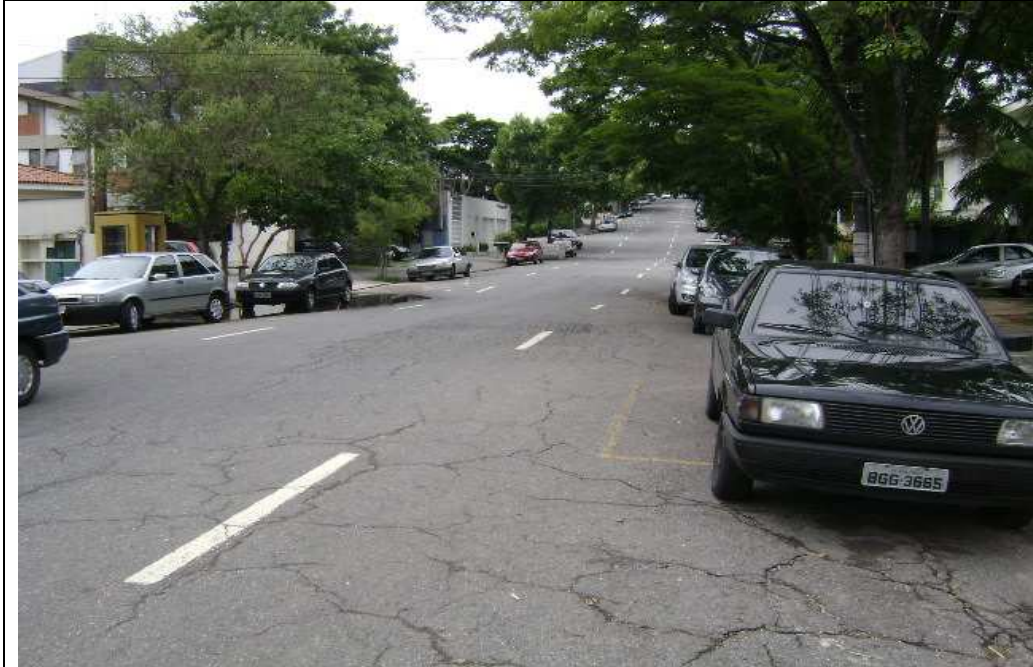
Rua Alvarenga – alagamento nos dois lados da via, com Rua Esperanto ao fundo -fev/09
