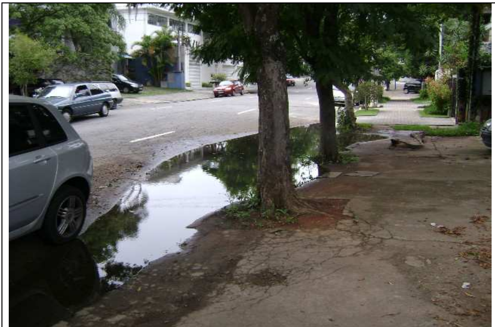
Ponto de alagamento na Rua Alvarenga - da R. Esperanto (ao fundo) para R. Camargo - fev/09
